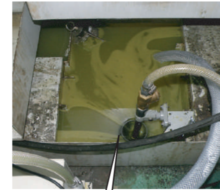
回収された浮上油 (浮上油は別タンクに回収)
